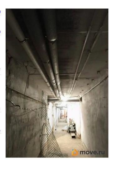
Состыковали старые чугунные трубы с новыми пластиковыми. Заняли пространство под потолком, уменьшили высоту проема на 50 см. Трубы холодной воды, горячей воды, отопления проходят по потолку. Отняли 30 см высоты потолков, раньше трубы коммуникаций проходили по стене.
